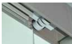
2 Sensores para el control de apertura de las ventanas correderas
